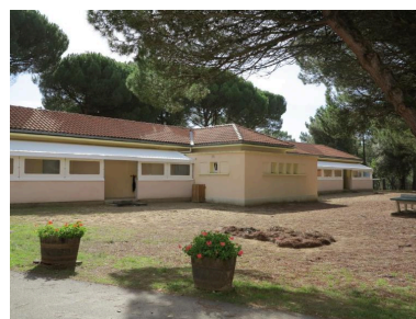
Un des blocs de dortoirs, côté sanitaires. Phot. Yannis Suire IVR54_20141706096NUCA
