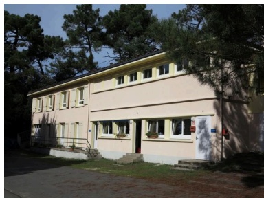
Le bâtiment qui regroupait la buanderie, à droite, et les logements du personnel, à gauche. Phot. Yannis Suire IVR54_20141706094NUCA
