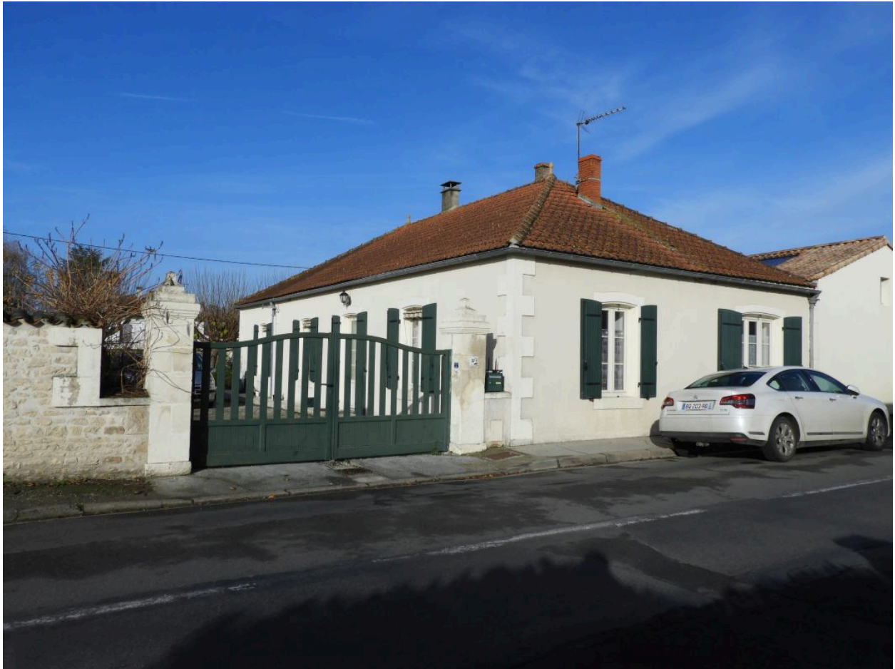
La maison vue depuis le sud-est.
