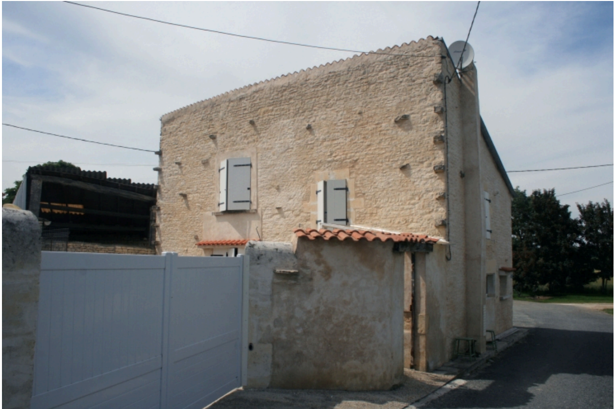
L'ancienne dépendance, depuis le sud-est.
