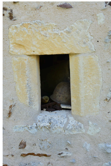
Fenêtre sur l'élévation ouest. Phot. Paul Maturi IVR75_20198604271NUCA
