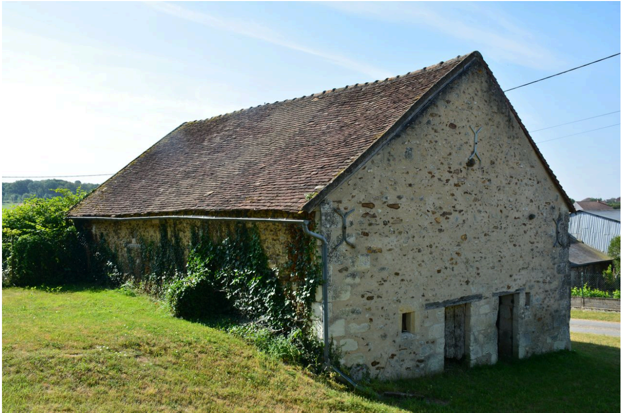
Élévation ouest de la grange.
