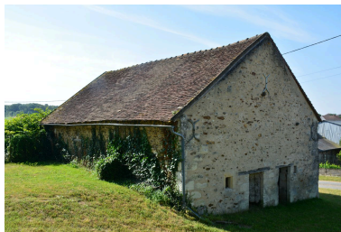
Élévation ouest de la grange. Phot. Paul Maturi IVR75_20198604270NUCA
