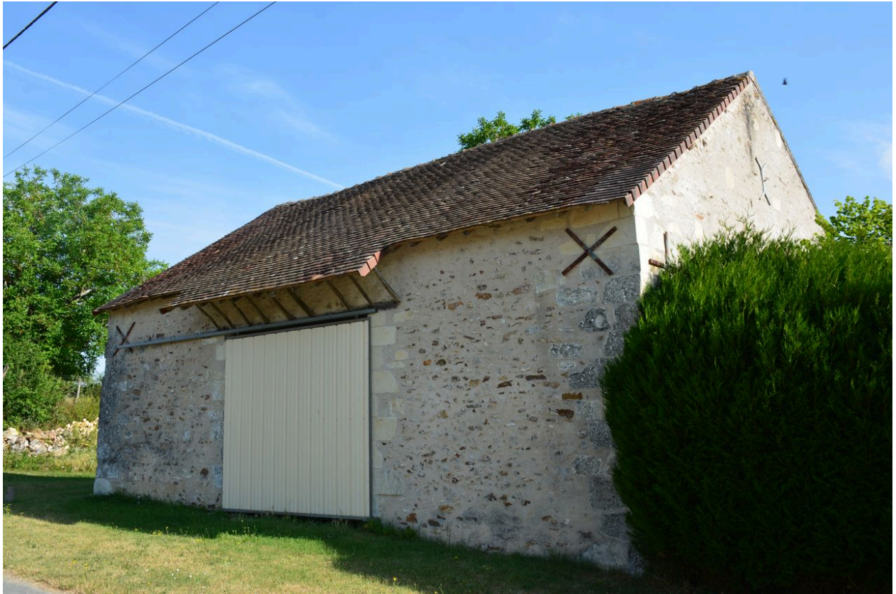
Élévation sud de la grange.
