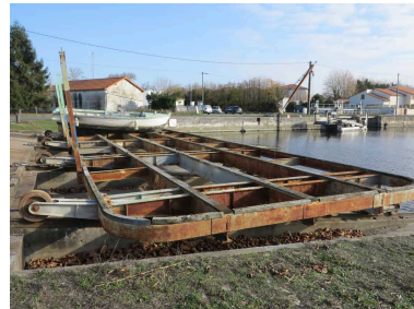
Le grill mobile au centre de la cale. Phot. Yannis Suire IVR54_20171705214NUCA
