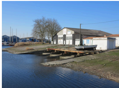
La cale vue depuis l'est. Phot. Yannis Suire IVR54_20171705210NUCA
