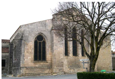
Chevet depuis l'est. Phot. Aline Carpentier IVR54_20031700848NUCA
