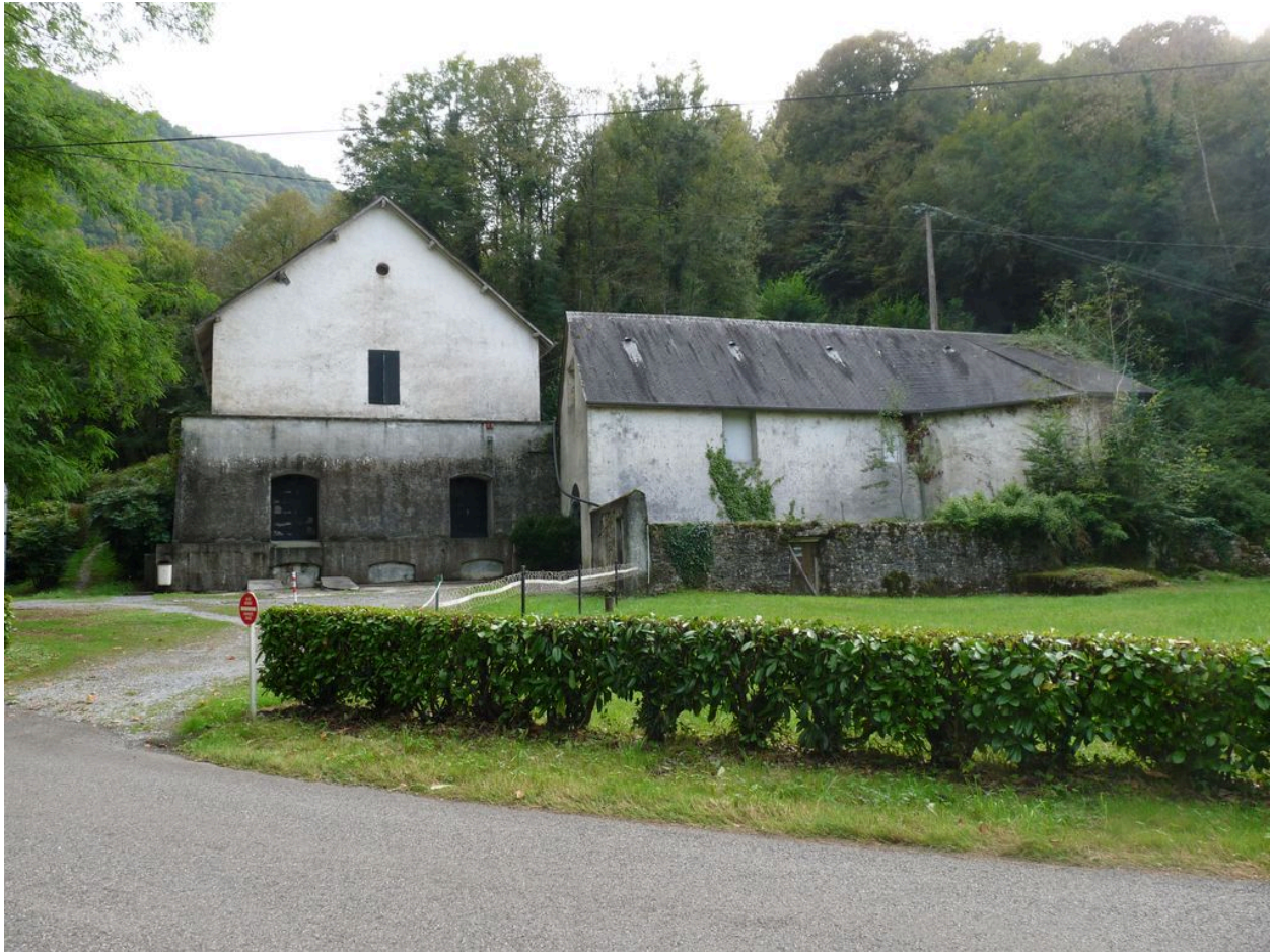
Parvis de la chapelle, entrepôt d'embouteillage et buanderie. Emplacement de la nouvelle buvette et des Bains Vieux.
