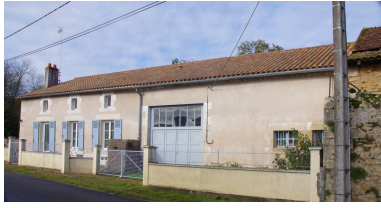
Vue de la façade est. Phot. Myriam Favreau IVR75_20198609880NUCA
