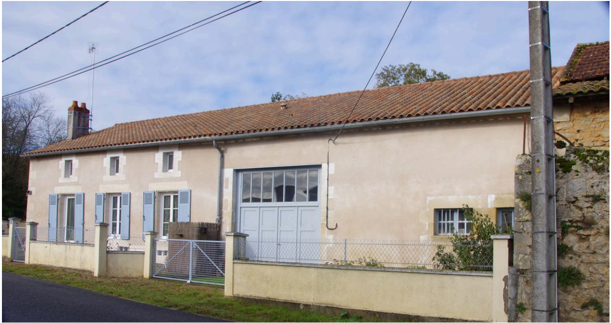
Vue de la façade est.
