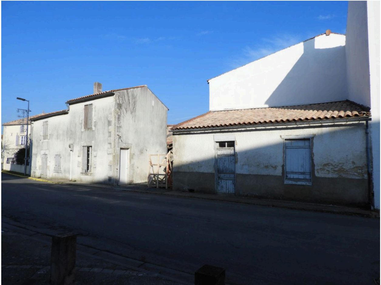
La maison, à gauche, et l'ancien café, à droite, vus depuis le sud.
