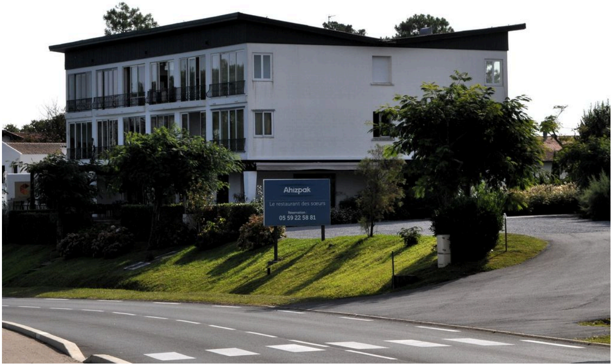
Vue de l'ancien hôtel depuis sud-ouest.
