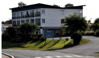
Vue de l'ancien hôtel depuis sud-ouest. Phot. Maïté Ehlinger IVR72_20186401622NUC2A
