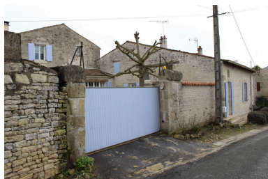
Une vue d'ensemble. Phot. Pierrick Barreau IVR54_20161710545NUCA
