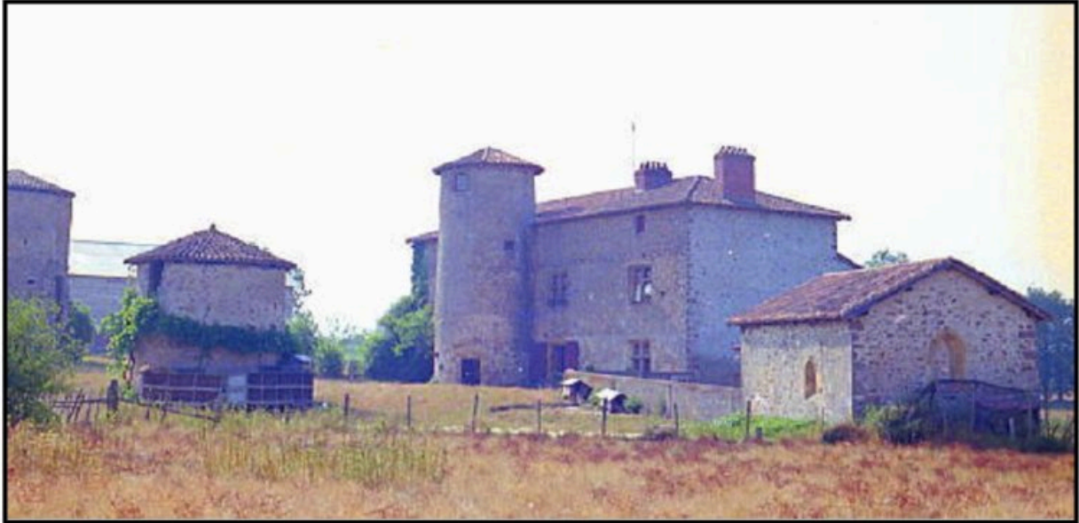
Manoir, vu depuis le sud-est, en 1984.
